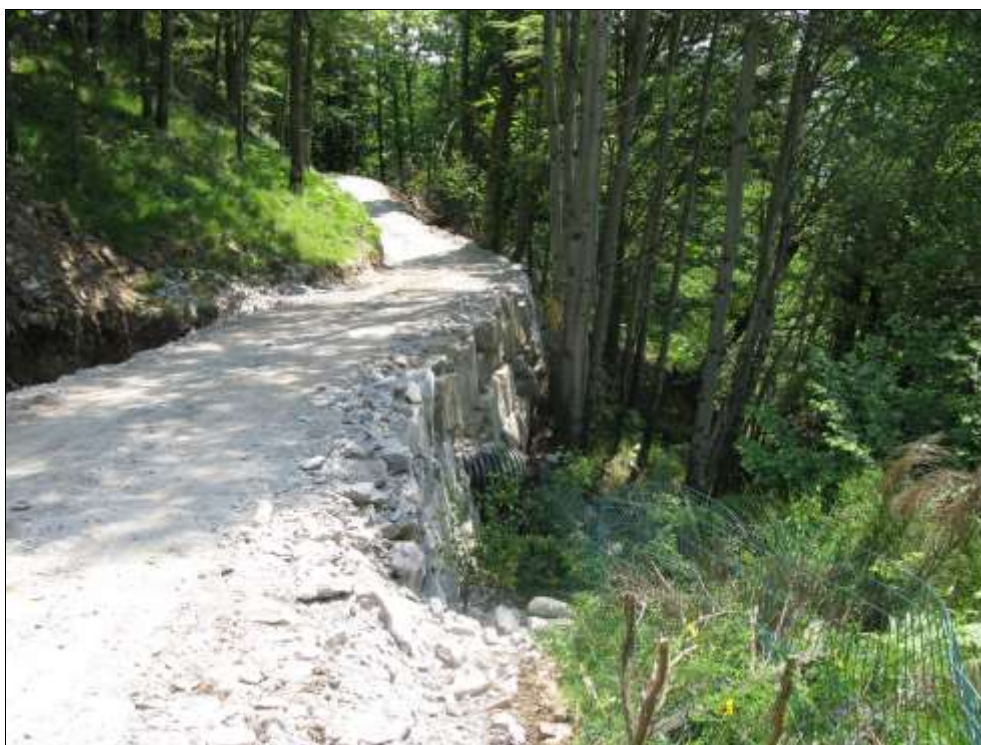
Esempio di scogliera di contenimento di valle
