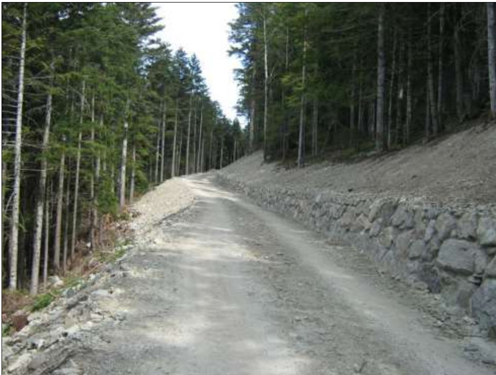
Esempio di scogliera di contenimento contro scarpa a monte
